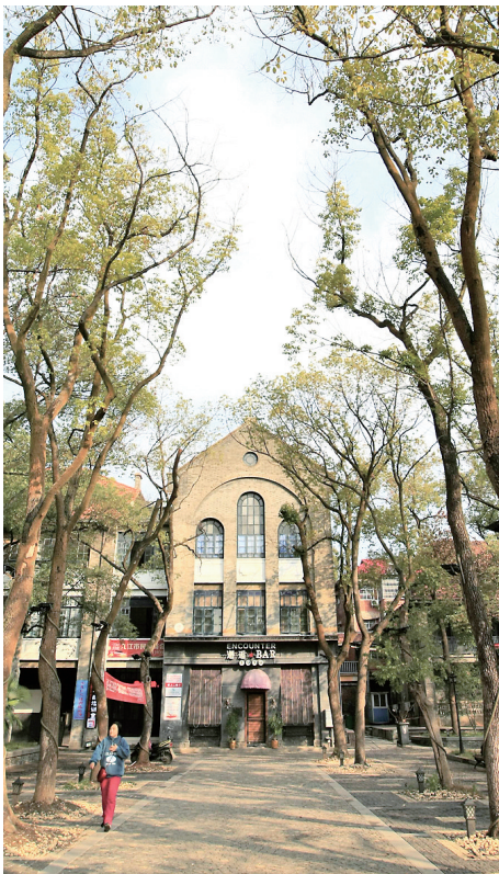
▶右图为九江修道院旧址。
